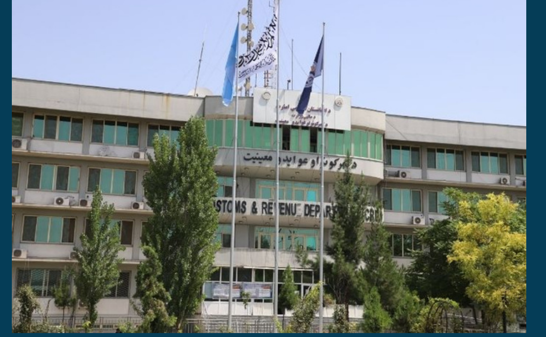
AFGANİSTAN GÜMRÜK BİNASI ELEKTRİK VE MEKANİK ALTYAPI KURULUMU PROJESİ
