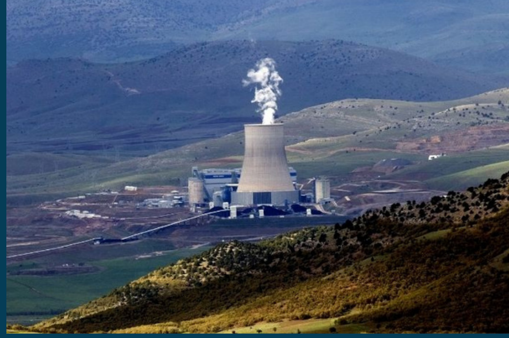
TUFANBEYLİ TERMİK SANTRALİ ENSTRÜMAN MONTAJI VE DEVREYE ALMA PROJESİ
