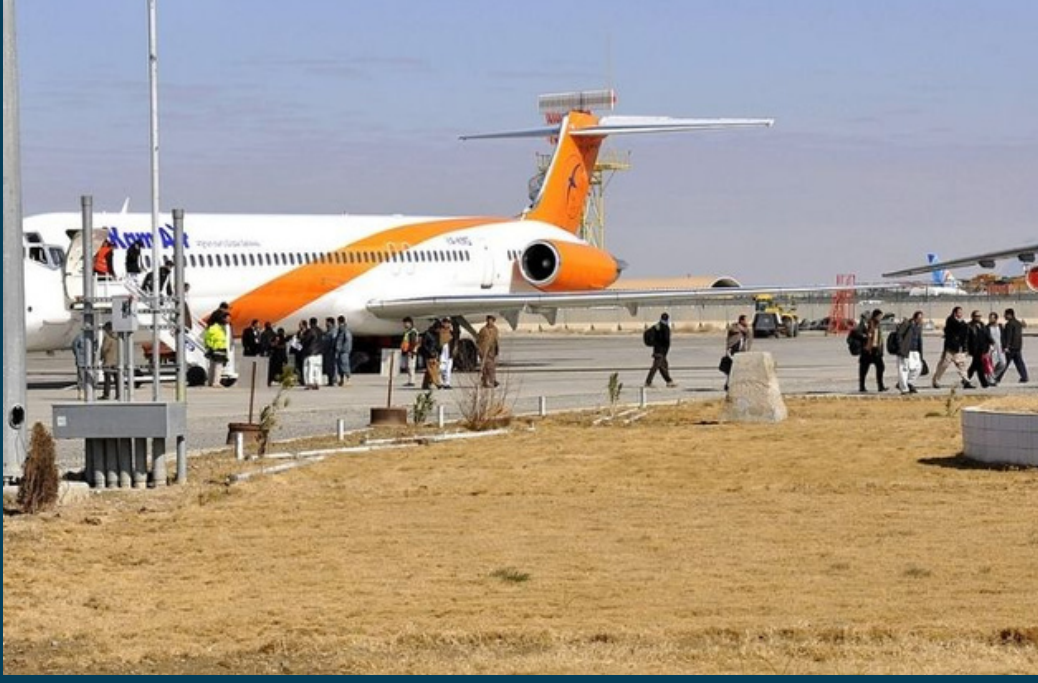
AFGANİSTAN KANDAHAR APRONU ELEKTRİK ALTYAPI KURULUMU PROJESİ
